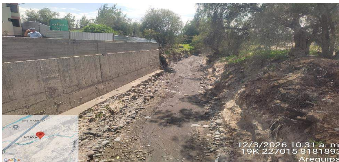
IMAGEN 02: SE OBSERVA LA MARGEN IZQUIERDA QUE REQUIERE DE UN MURO DE CONTENCION AGUAS ARRIBA Y EVITAR LA POSIBLE AFECTACION A VIVIENDAS, FAMILIAS Y CULTIVOS
