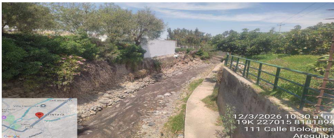
IMAGEN 01: SE OBSERVA LA COLMATACION DEL CAUCE DE LA QUEBRADA LOS INCAS AGUAS ARRIBA, SE REQUIERE DE LA CONSTRUCCION DE MURO DE CONTENCION
